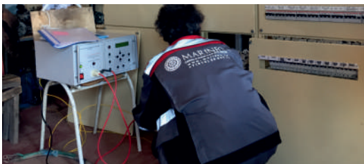
Компания «Маринэк» осуществила поставку, монтаж и пусконаладку главного распределительного щита 220В для теплохода "РТ-378" и успешно провела испытания его диэлектрической прочности.
